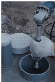
塩ビフタの高さを考慮して切断された立ち上がりパイプ
