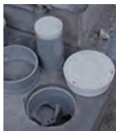
塩ビフタの高さを考慮して切断された立ち上がりパイプ
