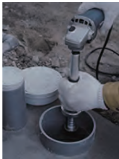
塩ビフタの高さを考慮して切断された立ち上がりパイプ
