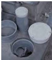
塩ビフタの高さを考慮して切断された立ち上がりパイプ
